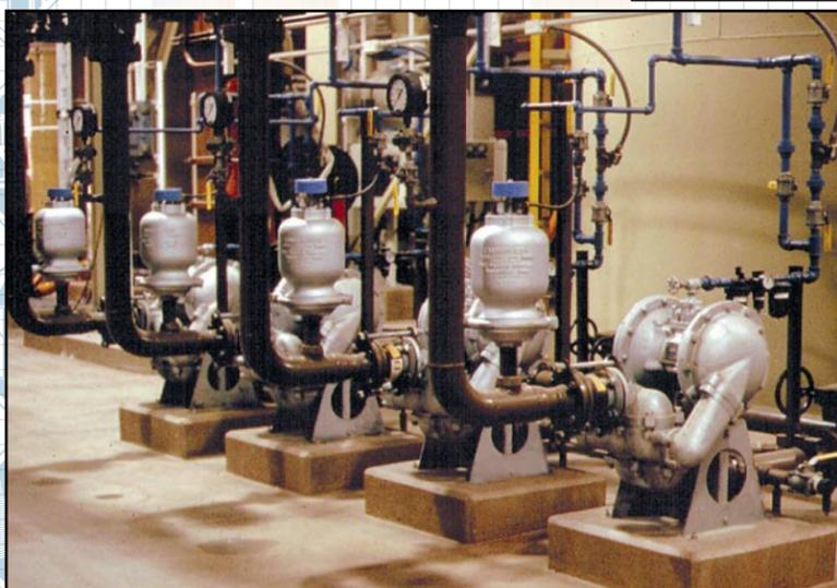
Bombas HDB de puerto de descarga inferior con Tranquilizers instalados en una planta de tratamiento de aguas residuales industriales.
