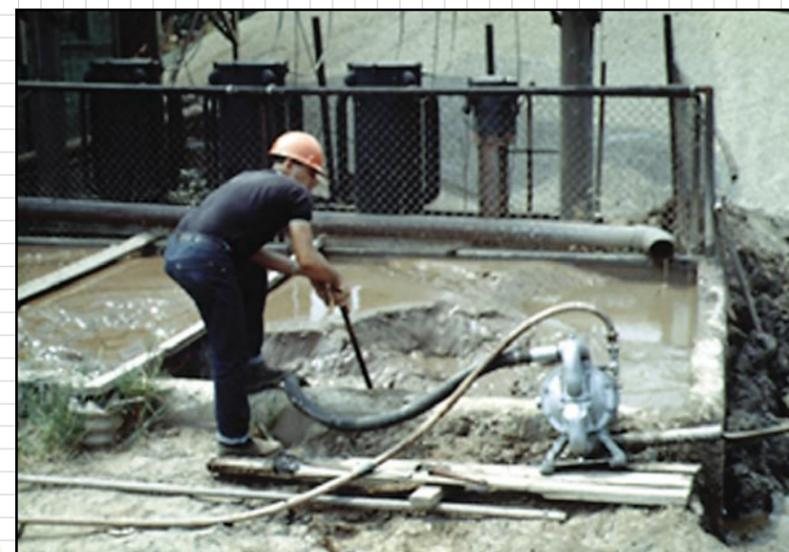
Bomba de válvula de gozne de uso rudo instalada temporalmente para bombear el cieno de un estanque. (No se requiere una alineación perfecta.)
