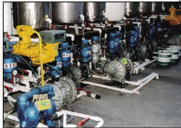
**Bombas metálicas de tarea de contención y Tranquilizers instalados en una planta de procesamiento químico.**
