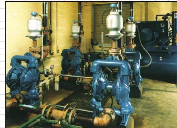
**Bombas metálicas de tarea estándar instaladas permanentemente en una operación de bombeo de sentina interior de la industria química.**
